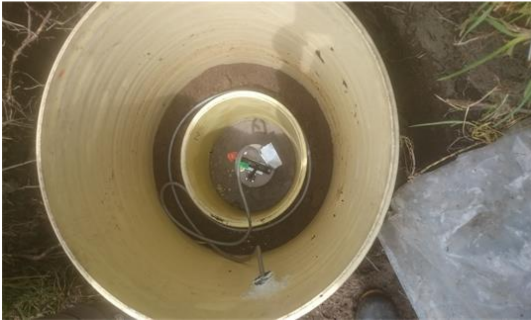
Figura 76. Mejoramiento de la instalación del sismómetro en la estación SANTA MARTA.
