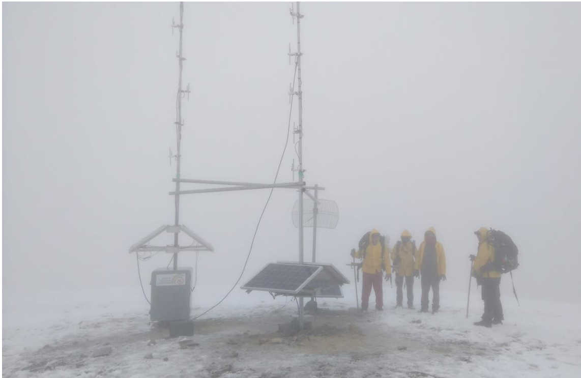
Figura 16. Nueva repetidora de comunicaciones OLLETA3.
