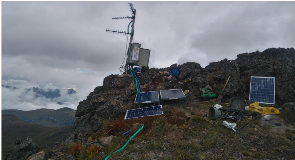
Figura 107. Estación multiparamétrica PARAMILLO.
