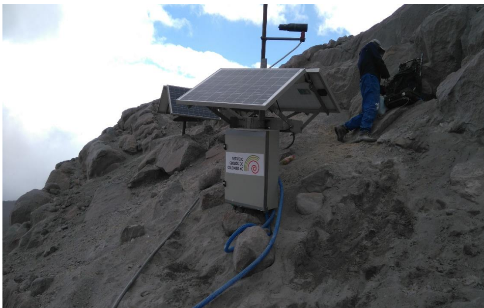
Figura 12. ScanDoas de la estación multiparamétrica REFUGIO.
