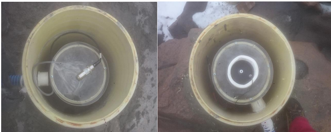
Figura 18. Sensores acústicos de infrasonido instalados en la estación multiparamétrica OLLETA2.
