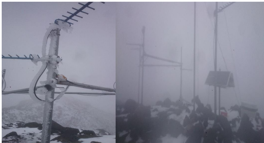
Figura 9. Acumulación de hielo en las antenas del repetidor EL CISNE.
