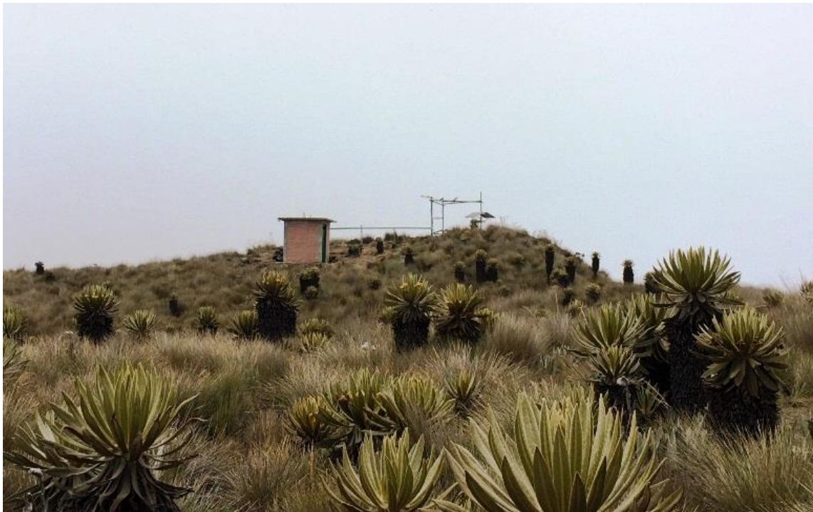
Figura 3. Estación repetidora EL CAMION.
