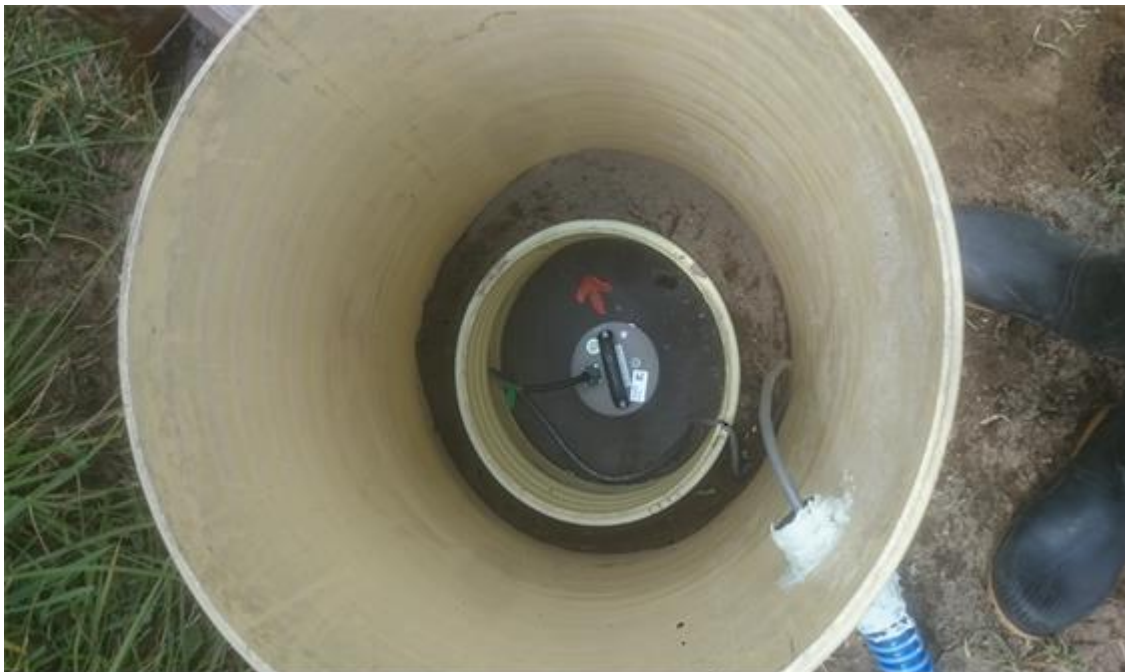
Figura 77. Mejoramiento de la instalación del sismómetro en la estación SILENCIO.
